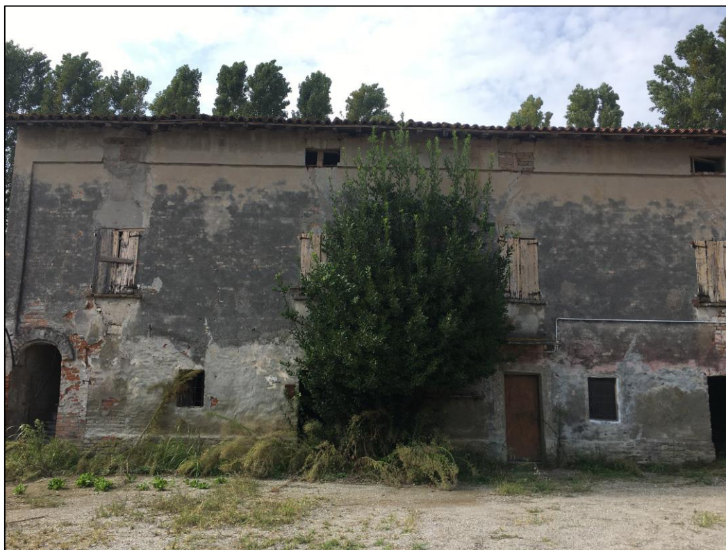
Figura 6 - Particolare del prospetto della Cascina Bassa che evidenzia le condizioni di degrado delle coperture. In questa porzione di immobile troverà collocazione la Foresteria (intervento non compreso nel presente progetto)
